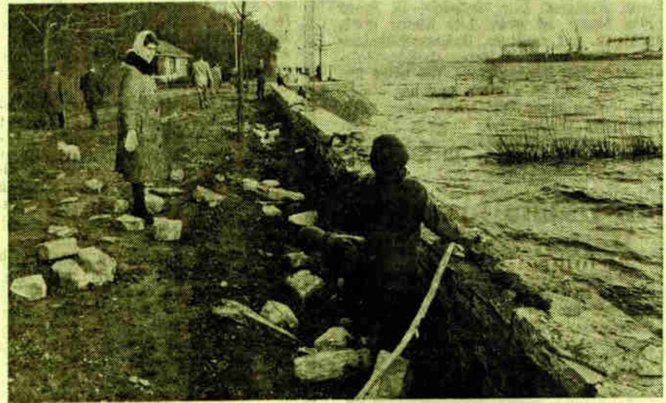
So wütete die Sturmflut: Beschädigter Elbufer-Wanderweg bei Nienstedten
