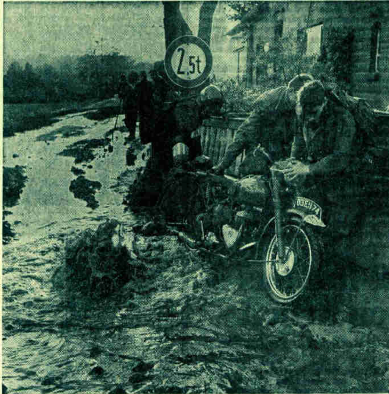
In Moisburg (Kreis Harburg) brach unter dem Druck der Kettenfahrzeuge ein Wasserrohr mit Verteiler. Folge: Die Straße ist fast unpassierbar.
